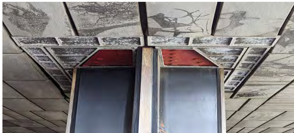
Foto dettaglio pilastro cruciforme con controsoffitto Marotta
